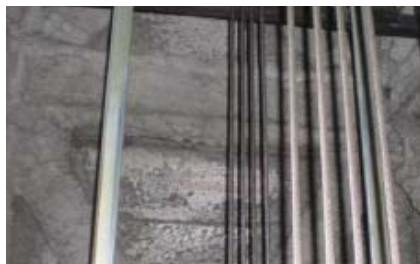
エレベーターシャフト内部
